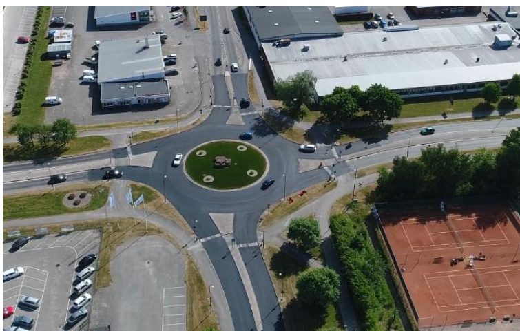
Figur 3 Exempelvy korsningen Hollendergatan-Odengatan från drönaren
